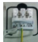
Conexión por el exterior de la luminaria
